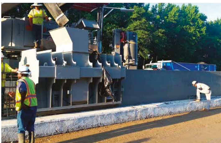
Устройство ограждения при работе со смещением
