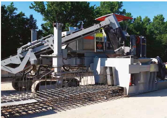
Укладка основания ограждения при работе со смещением и другие случаи индивидуального использования
