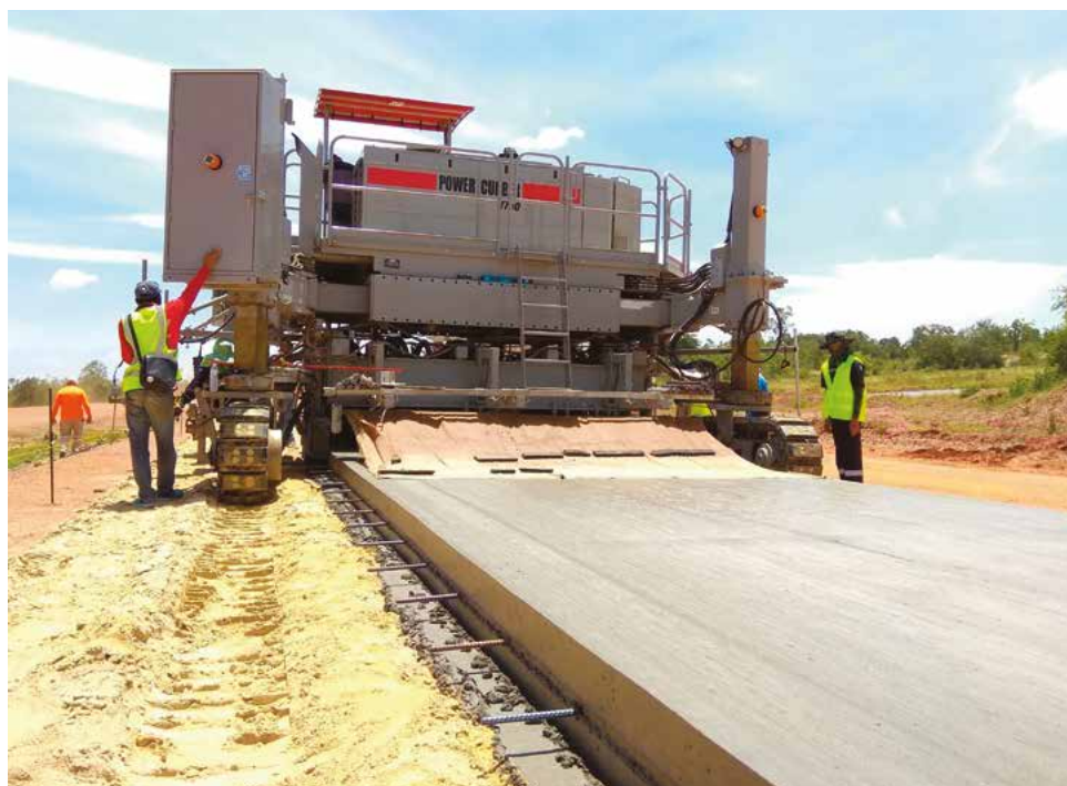
Конфигурация для укладки на ширину 3,5 м при высоком подъеме на 6,7%
